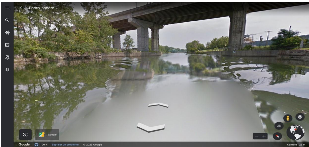
Photo 6c - Obstacle (O2) du viaduc route 138 - Vue de l'eau - Direction départ
